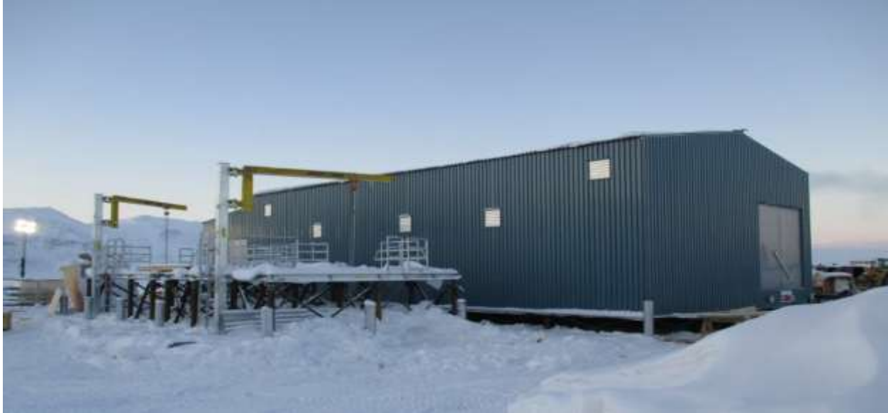
Construction de la centrale de Qikiqtarjuaq, novembre 2014
